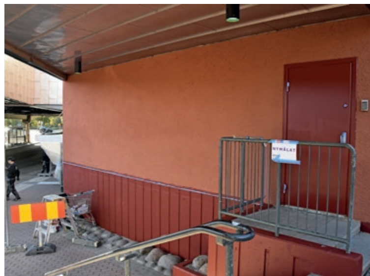
Trappan som leder från busstorget upp mot ingången vid Toscanini är nymålade.
