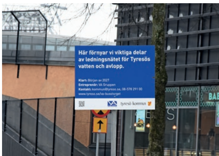
Nu börjar det omfattande arbetet med att flytta och förnya ledningsnätet under busstorget.
