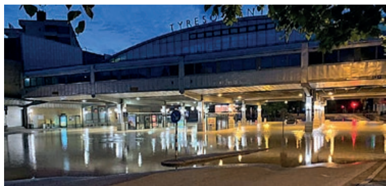
I juni 2021 inträffade en allvarlig vattenläcka.
